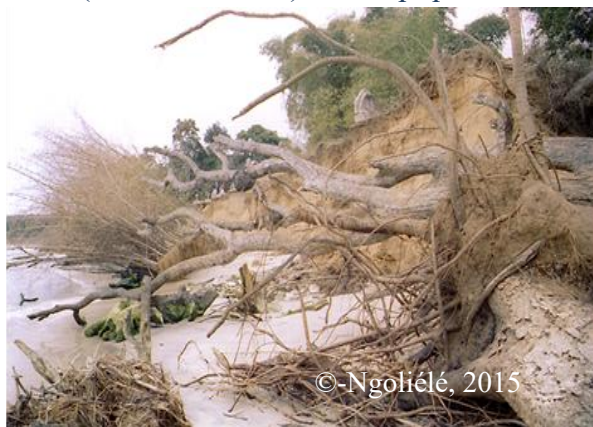
Photo 38. Erosion côtière (Baie de Loango)
